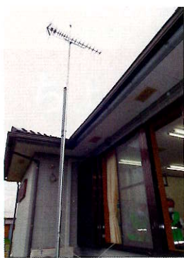
自前で設置した無線機用アンテナ
